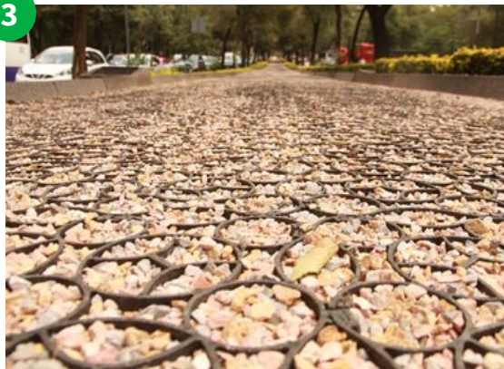
Instalación de rejilla gravalock
