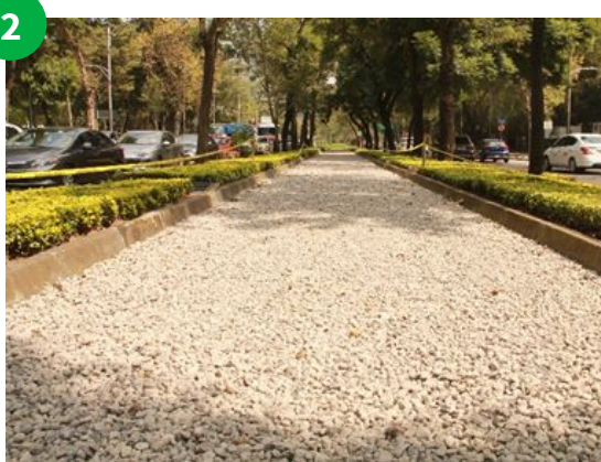
Colocación de cama de grava de \frac{3}{4} " de 10 cm de espesor como filtro compactado
