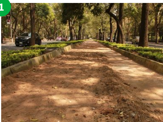
Limpieza y nivelación del terreno
