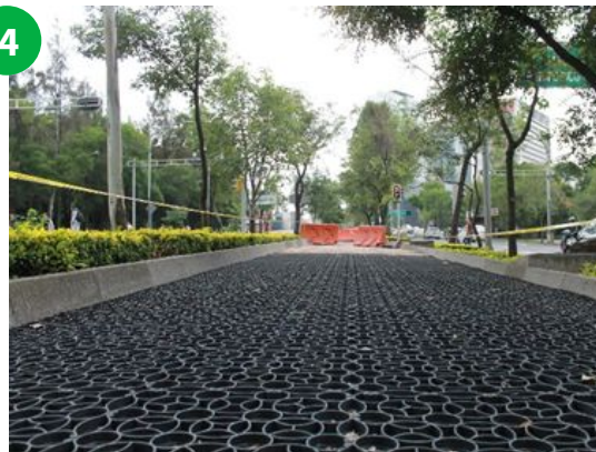
Relleno de gravilla en la rejilla gravalock
