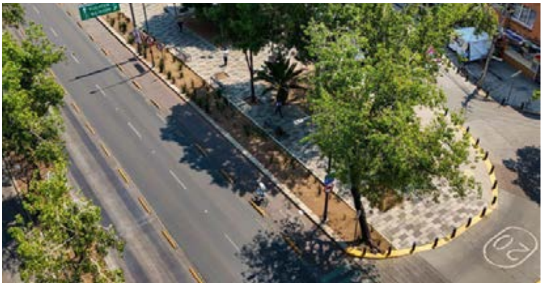
Fotografía 9. Intersección de av. Insurgentes y calle Chilpancingo
