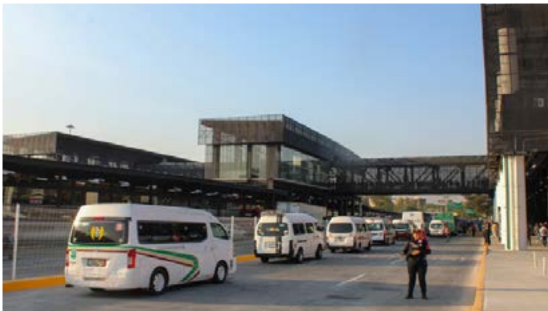
Fotografía 34. Remodelación integral del CETRAM Indios Verdes 70
