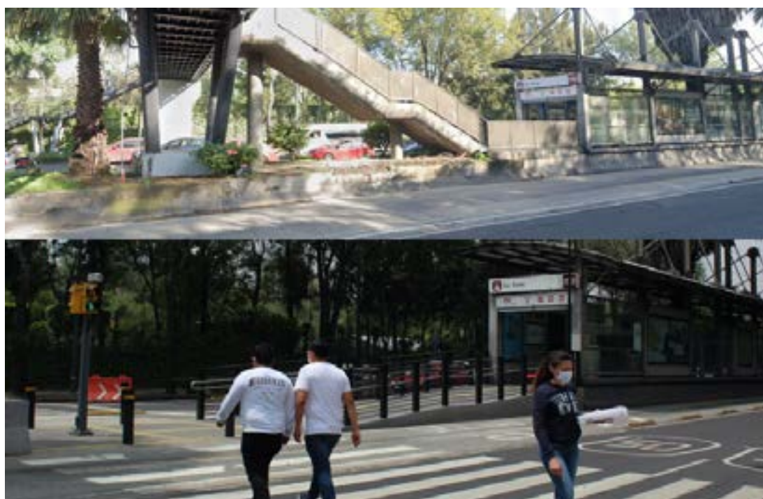
Fotografía 10. Antes y después de la intervención de cruce seguro en la estación San Simón del Metrobús. 24
