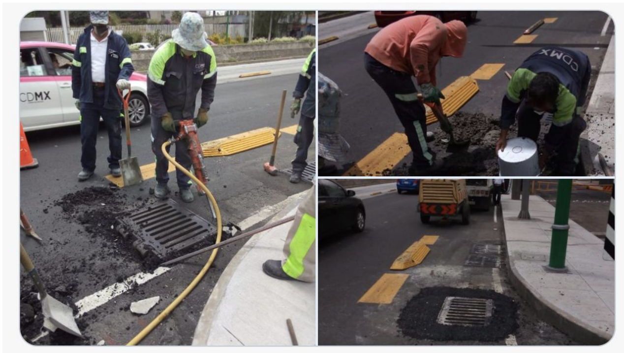
MEJORA Y COLOCACIÓN DE REJILLAS Y COLADERAS
