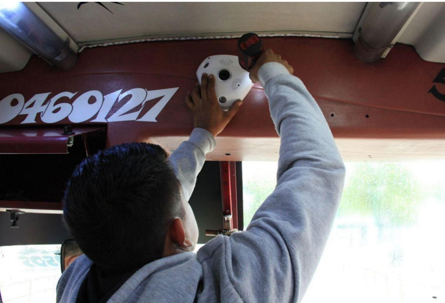
Foto 44 | Instalación de cámaras y GPS en las unidades de transporte público
